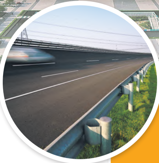
上海大众汽车试验场工程荣获鲁班奖、詹天佑奖和全国用户满意建筑工程奖
