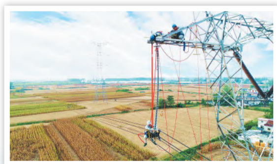
对500千伏线路进行带电更换绝缘子串，确保可靠供电
