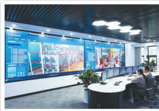
古泉换流站创新智慧运检模式，对检修进行远程管控
