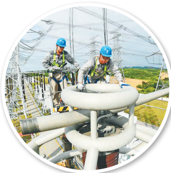
变检人员在特高压芜湖站主变扩建现场检修设备
