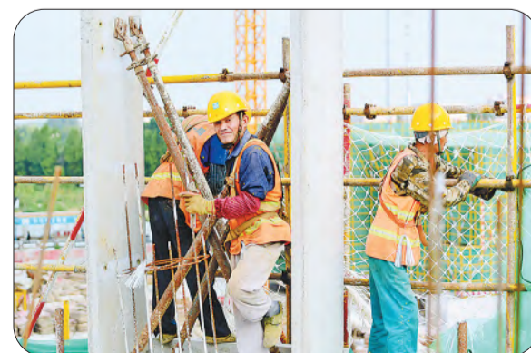
错峰施工避高温
