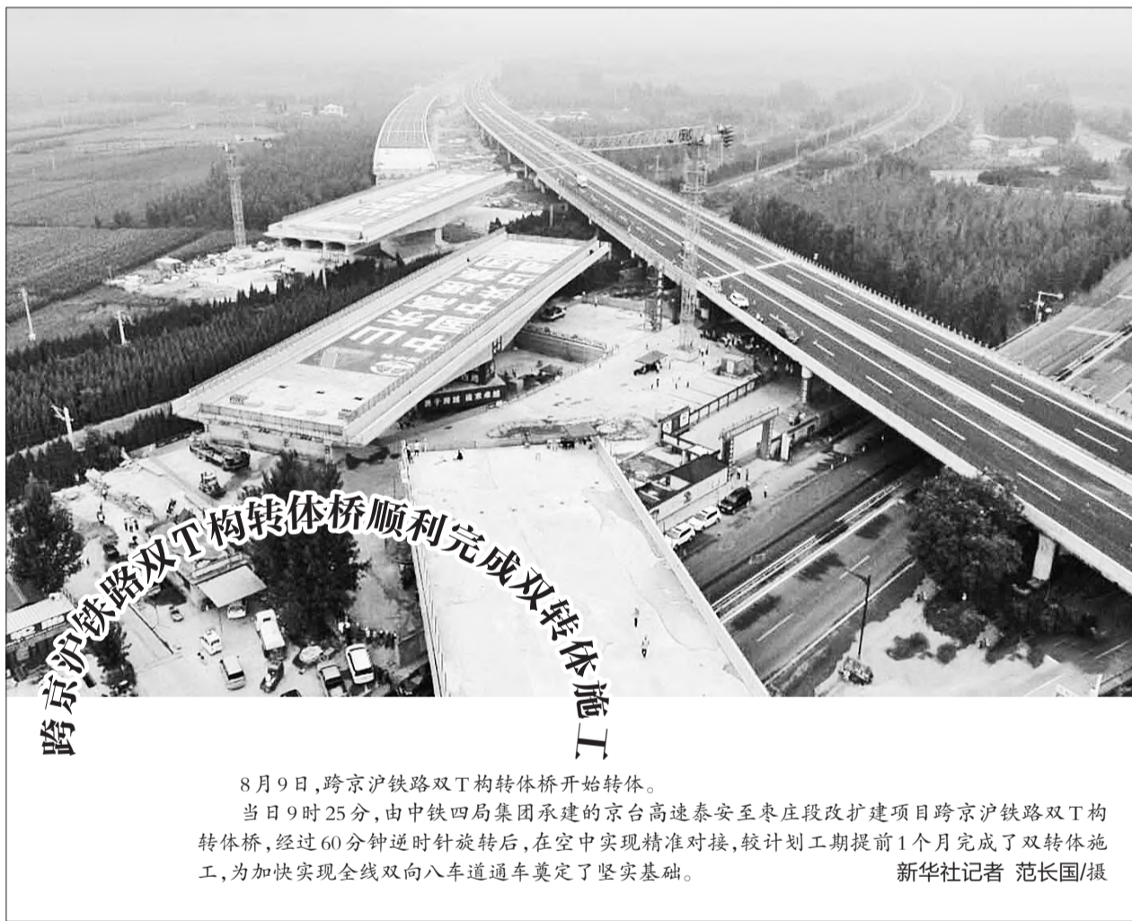
8月9日,跨京沪铁路双T构转体桥开始转体。当日9时25分,由中铁四局集团承建的京台高速泰安至枣庄段改扩建项目跨京沪铁路双T构转体桥,经过60分钟逆时针旋转后,在空中实现精准对接,较计划工期提前1个月完成了双转体施工,为加快实现全线双向八车道通车奠定了坚实基础。 新华社记者 范长国/摄
