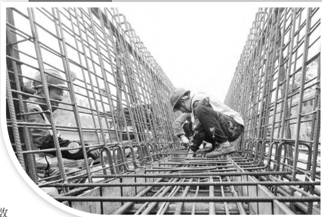
5月4日，G42S上海至武汉高速公路无为至岳西段，工人们正在岳西县莲云乡九标梁场施工。“五一”假期，建设者们以饱满的工作热情坚守岗位，确保项目如期推进。吴均奇/摄
