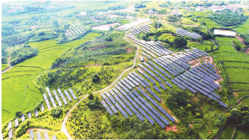
金寨龙窝100MW农光互补电站项目
