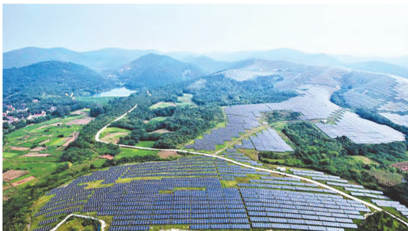
巢湖50MW山地光伏电站项目
