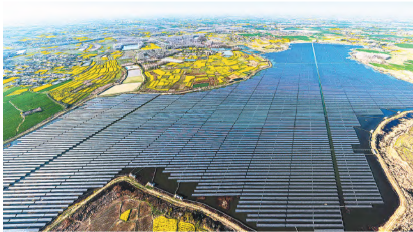
肥东梁园100MW渔光互补电站项目
