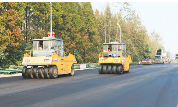
S307亳州段路面改建工程
