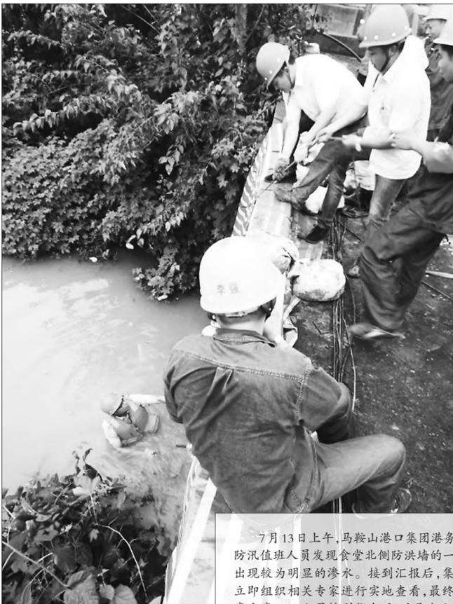
7月13日上午，马鞍山港口集团港务三公司防汛值班人员发现食堂北侧防洪墙的一处裂缝出现较为明显的渗水。接到汇报后，集团公司立即组织相关专家进行实地查看，最终确定初步方案。三公司接到指令后，立即组织党员抢险突击队，支部书记亲自带头指挥；工会主席配合组织人员兵分三路进行抢险。经过近3.5个小时的奋战，当晚8时，渗水处的江水终于得到有效封堵，险情得到初步控制。刘玮/摄
