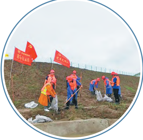
瓦埠湖项目部党员先锋队、青年突击队防汛抢险
