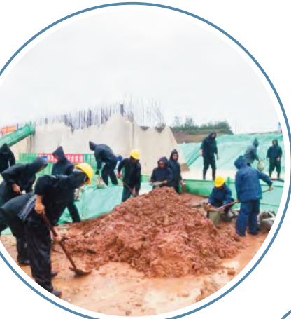
引江济淮项目部组织对基坑内挡水坝进行加高
