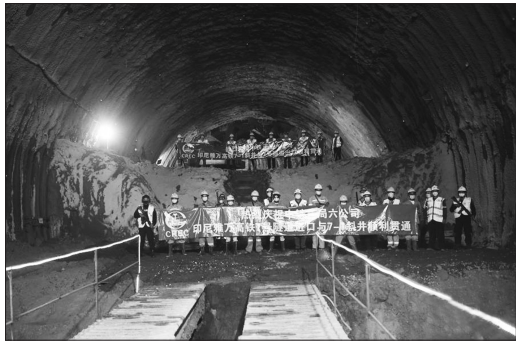
印尼雅万高铁首座千米以上隧道顺利贯通
