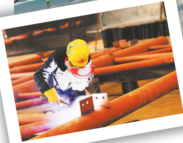
铜陵有色金属集团铜冠建筑安装股份有限公司员工为“金冠道选”项目抢工期。黄也文/摄
