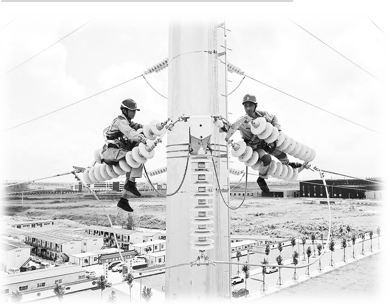
9月20日,在定远县练铺村,电力工人正在50多米高的铁塔上进行放紧线施工作业。当日是中秋节小长假第二天,为确保滁州市“十四五”期间首个电网输变电工程——220千伏鲁肃输变电工程按期竣工投产,滁州市供电公司 and 安徽送变电工程有限公司的300余名电力建设者放弃了与家人团聚的机会,坚守在工作岗位上。 宋卫星 丁波 曹勇/摄
